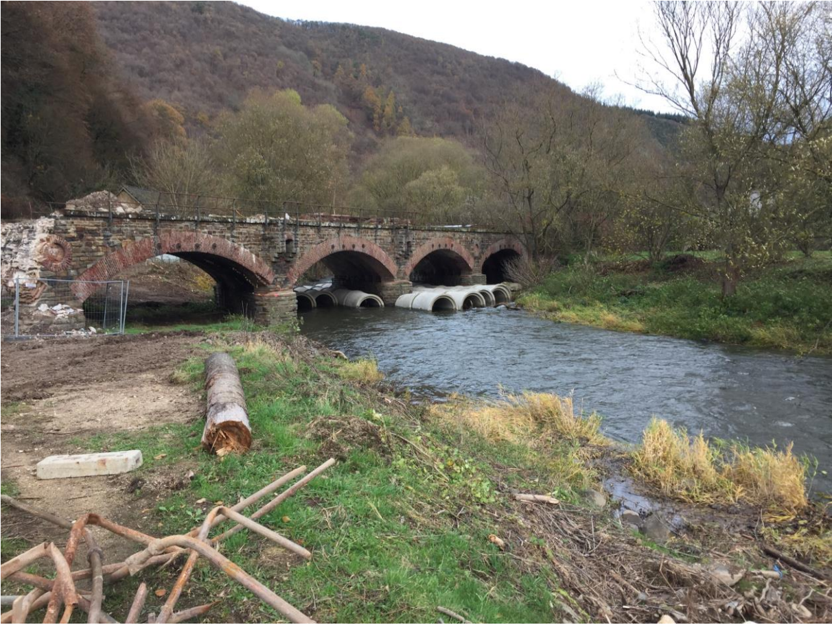
Oberhalb Eisenbahnbrücke Ahrbrück Pegel 20.11.2016 11:00 Uhr Müsch 47 Altenahr 72
